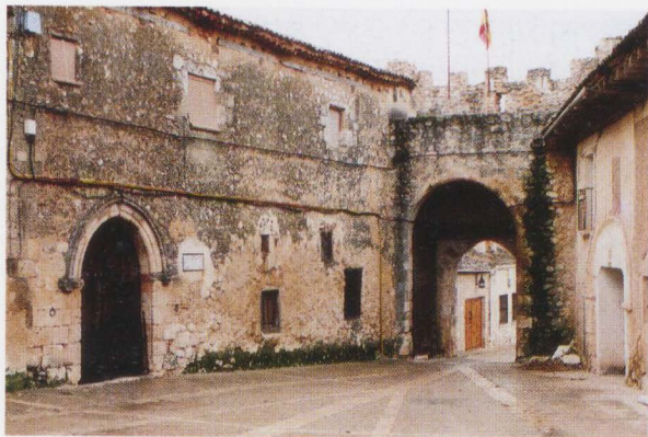
Puerta principal de entrada a Maderuelo vista desde el interior.
