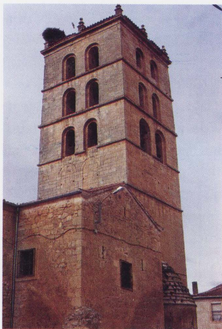
Campanario de la iglesia de Cedillo de la Torre.
